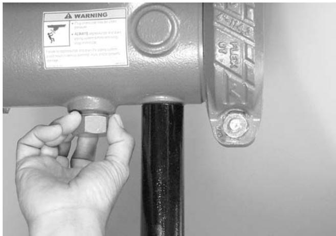
1. 시스템 내 압력이 완전히 제거되었는지 확인하십시오. 시스템 온도가 100° F/38° C 밑으로 내려가도록 하십시오. 상기 그림과 같이 드레인 탭을 분리하여 석션 디퓨저내 유체를 배수하십시오.
