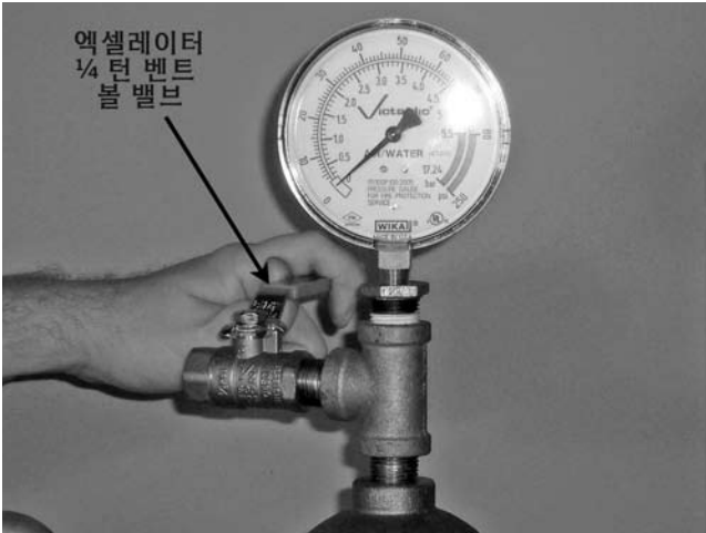
17. Series 746-LPA 드라이 액셀레이터가 설치되면, 1/4-턴 밸브 볼 밸브를 닫으십시오.
