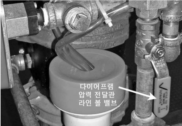
16b. 다이어프램 압력 전달관 라인의 압력이 낮아지지 않으면, 다이어프램 압력 전달관 라인의 볼 밸브를 다시 열고 다음의 과정을 따르십시오.
