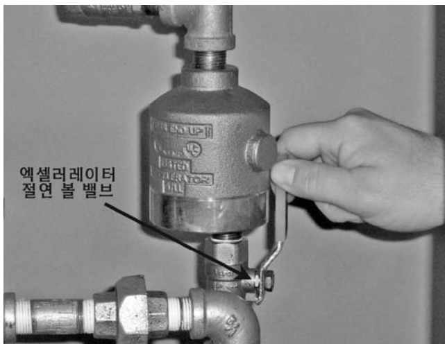
13. Series 746-LPA 드라이 엑셀레이터가 설치되면, 절연 볼 밸브를 여십시오.
