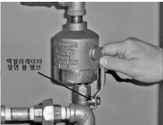
18. Series 746-LPA 드라이 액셀레이터가 설치되면, 절연 볼 밸브를 여십시오. 절연 볼 밸브를 열면 액셀레이터를 설정하게 됩니다.
