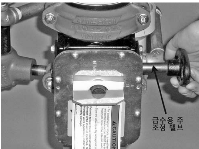
24. 물이 드립 체크로부터 흘러나오면, 급수용 주 조정 밸브를 닫고 1단계에서 다시 시작하십시오. “문제해결” 섹션을 참조하십시오.
