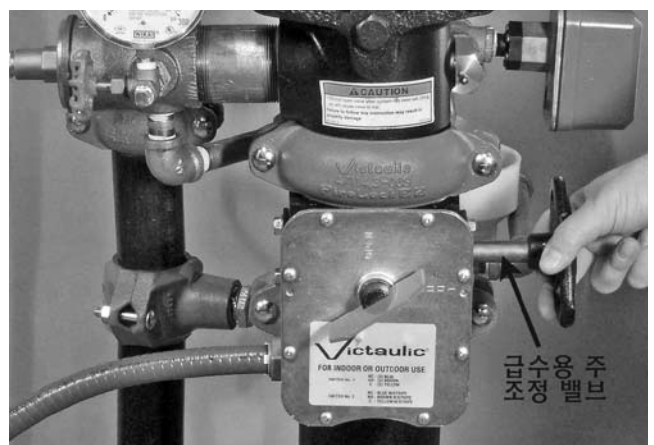
24. 열려있는 급수용 주 배수 밸브로부터 물이 꾸준히 흘러나올 때까지 급수용 주 조정 밸브를 열어 두십시오.
