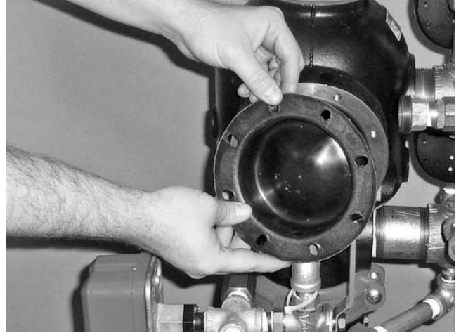
6. 다이어프램을 Victaulic이 공급한 새 다이어프램으로 교체하십시오. 다이어프램의 구멍과 밸브 본체의 구멍을 잘 맞추십시오. 설치 도중 다이어프램에 손상이 가지 않도록 주의하십시오.
