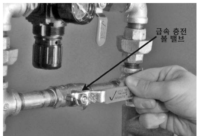
10. Series 757 에어 공급트림 어셈블리(에어 레귤레이터 부착형)의 급속충전 불 밸브를 여십시오. 정상수준의 시스템 압력에 이를 때 까지 압력을 올리십시오.
