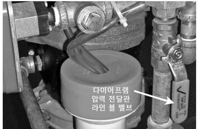
19b. 다이어프램 압력 전달관의 압력이 낮아지지 않으면, 다이어프램 압력 전달관의 볼 밸브를 다시 열고 다음의 과정을 따르십시오.
