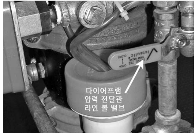
19. 다이어프램 압력 전달관이 압력을 받고 있을 때, 다이어프램 압력 전달관의 볼 밸브를 일시적으로 닫아 주십시오. 다이어프램 압력 전달관의 압력 게이지를 살펴 다이어프램 압력 전달관의 압력이 유지되고 있는지 확인해 주십시오.
