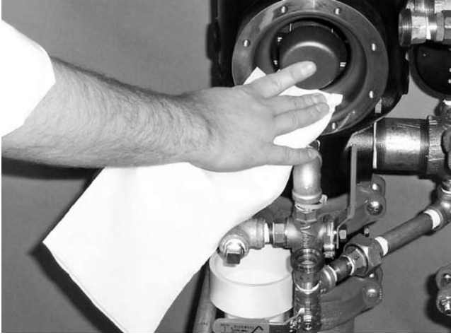
5. 밸브 본체 뒷면을 깨끗이 하여 다이어프램을 제대로 설치하는데 방해가 될 수 있는 파편을 제거하십시오.
