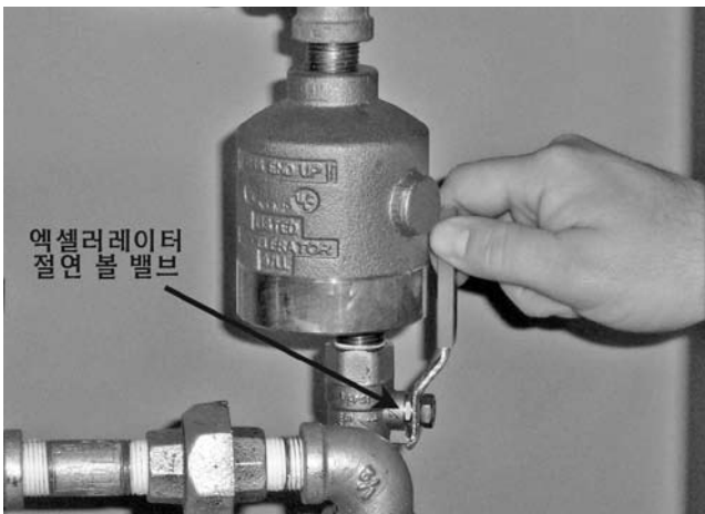
21. Series 746-LPA 드라이 액셀레이터가 설치되면, 절연 볼 밸브를 여십시오. 절연 볼 밸브를 열면 액셀레이터를 설정하게 됩니다.
